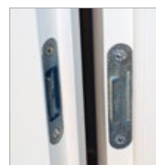
Bandseitensicherung
